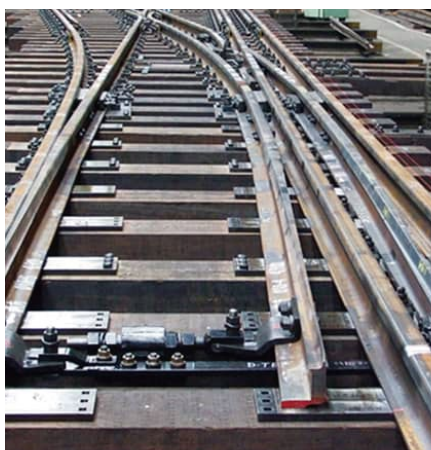
三線式分岐器 Dual Gauge Turnout
