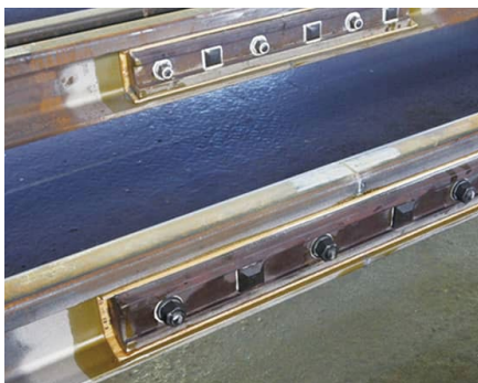
接着絶縁レール(JIS) Glued Insulated Rails
