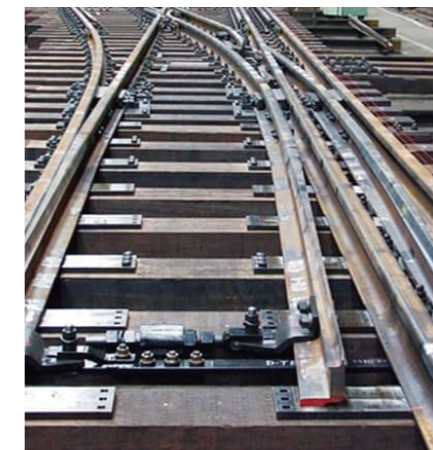
三線式分岐器 Dual Gauge Turnout
