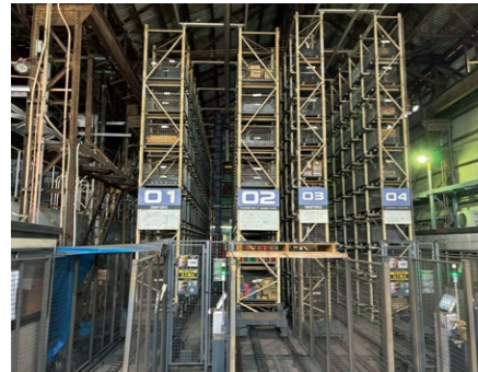
立体自動倉庫 Automatic Storage/ Retrieval System
