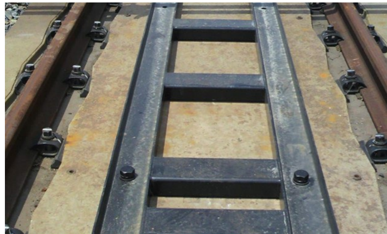
新幹線用逸脱防止ガード Deviation Prevention Guard for Shinkansen
