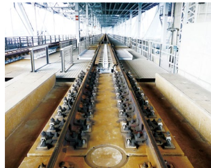
緩衝桁軌道伸縮装置1500形(瀬戸大橋線) Expansion Joint (Seto-ohashi Line)
