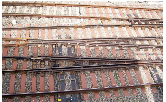
NEWノーズ可動クロッシング NEW Swing Nose Crossing
