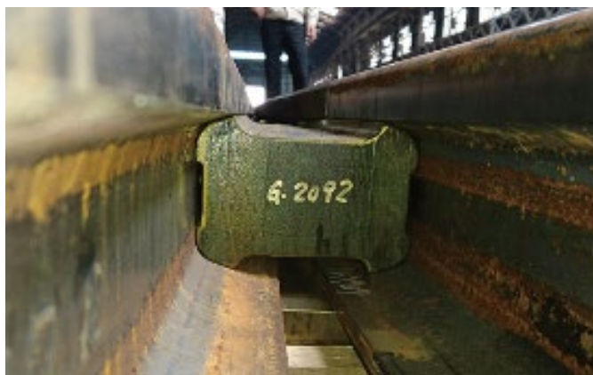
改良型ヒール間隔材 Improved Heel Block
