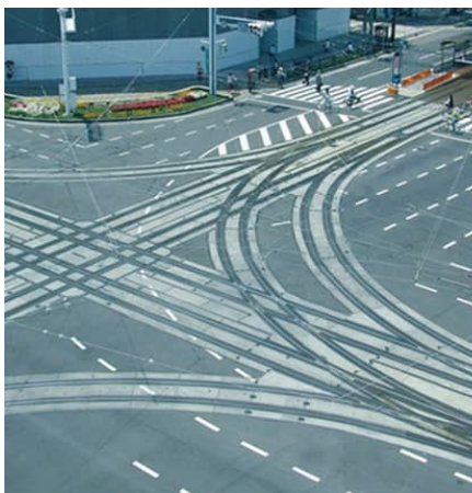
溝付レール製分岐器 (R=25m) Turnout with Grooved Rail (R=25m)
