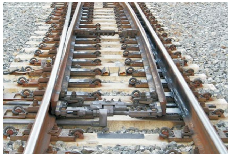
PCまくらぎ分岐器 PC Sleeper Turnouts
