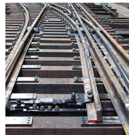
三線式分岐器 Dual Gauge Turnout
