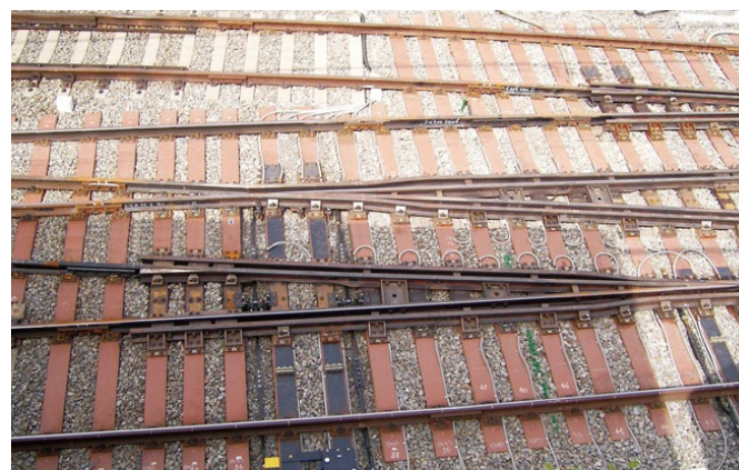
NEWノーズ可動クロッシング NEW Swing Nose Crossing
