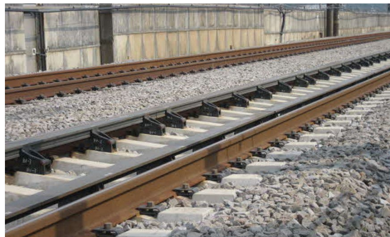
新幹線用脱線防止ガード Derailment Prevention Guard for Shinkansen
