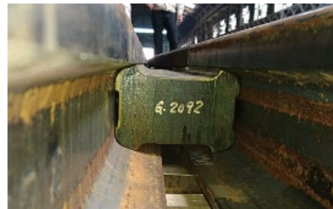
改良型ヒール間隔材 Improved Heel Block
