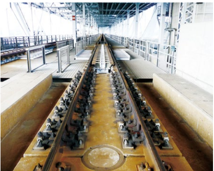
緩衝桁軌道伸縮装置1500形 (瀬戸大橋線) Expansion Joint (Seto-ohashi Line)
