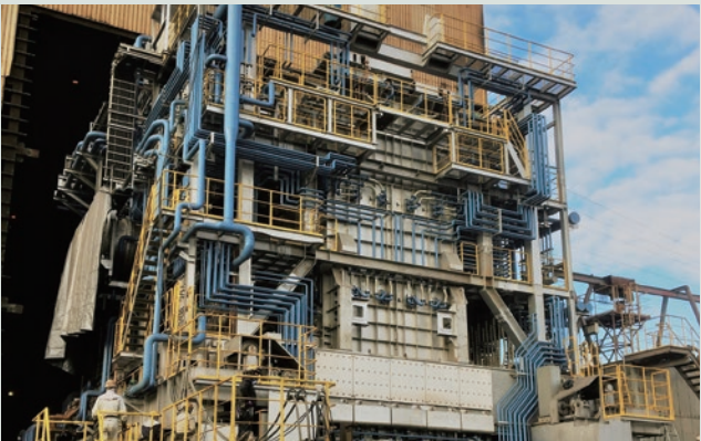
単段式炉頂スクラップ予熱装置(SSP)
