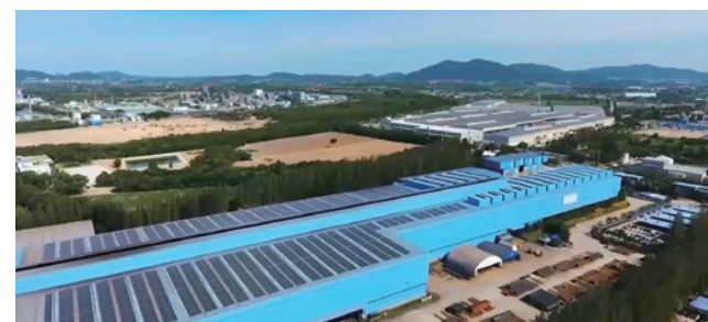
SYS工場屋上に設置された太陽光パネル
